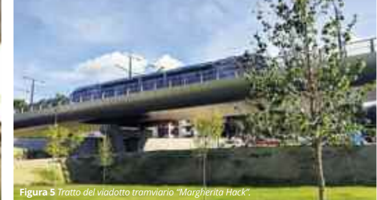
Figura 5 Tratto del viadotto tramviario "Margherita Hack".
