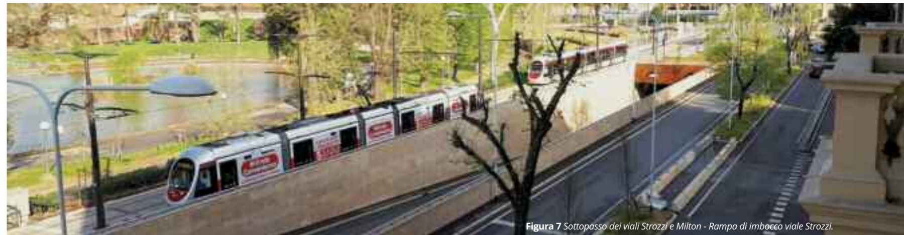
Figura 7 Sottopasso dei viali Strozzini e Milton - Rampa di imbocco viale Strozzini.
