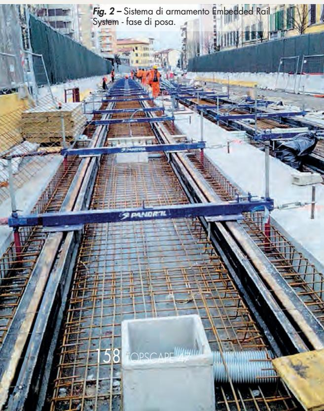
Fig. 2 - Sistema di armamento Embedded Rail System - fase di posa.
