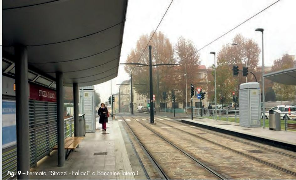
Fig. 9 - Fermata "Strozzi - Fallaci" a banchine laterali.
